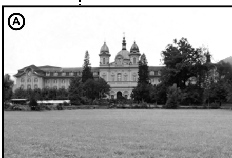
(A) Kantonsgericht Schwyz Kollegiumstrasse 28 (Gebäude Kantonsschule Kollegium Schwyz KKS)
